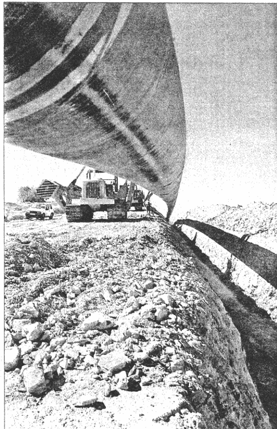
Construcción de un gasoducto por parte de Enagás.
